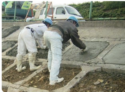
法面保護工事
