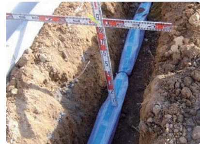
配水管布設工事
