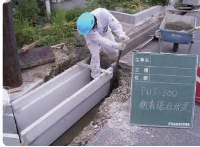
側溝布設工事
