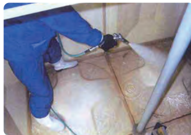
高圧洗浄 状況
